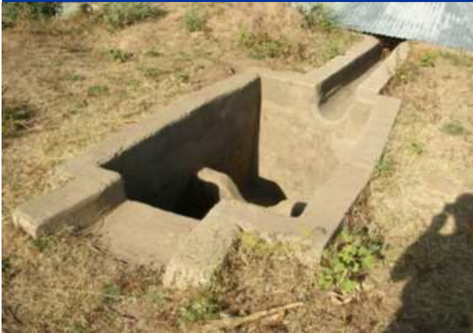
Cisterne per l'acqua,
